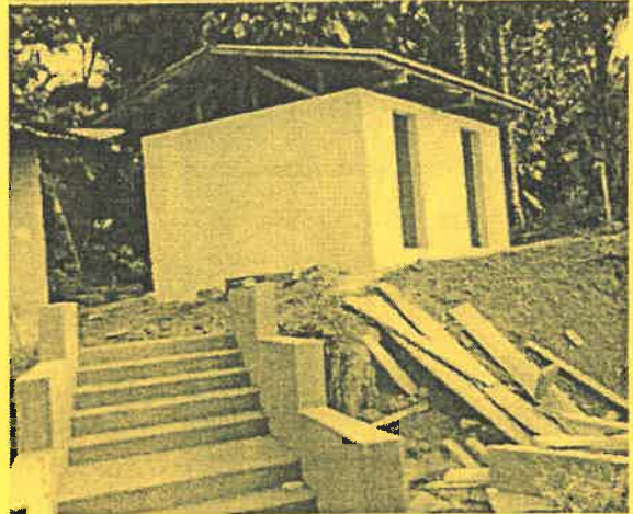
Die neuen Sanitäranlagen für das “Centre de Santé” in Zoetele
