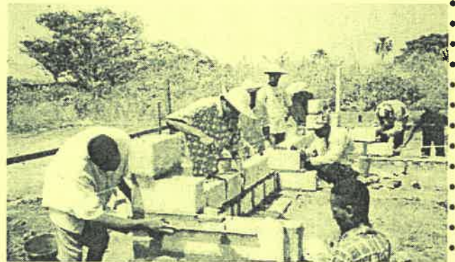
Die Maurer beim Hochziehen der Wände
