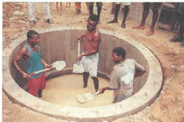
Nur mit viel Mühe und unter höchster körperlicher Anstrengung gelang es, einen Wasserspeicher in das harte Erdreich zu treiben
