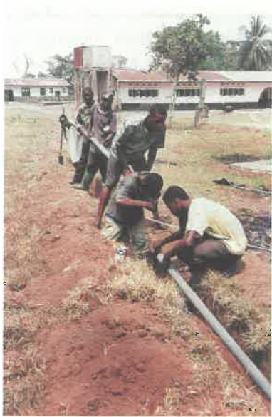
Die Wasserleitung zum Krankenhaus wird verlegt
