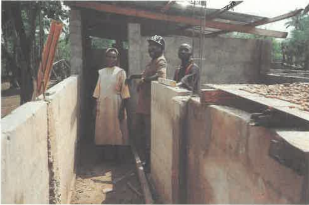
Zufriedene Gesichter kurz vor dem Abschluss der Bauarbeiten
