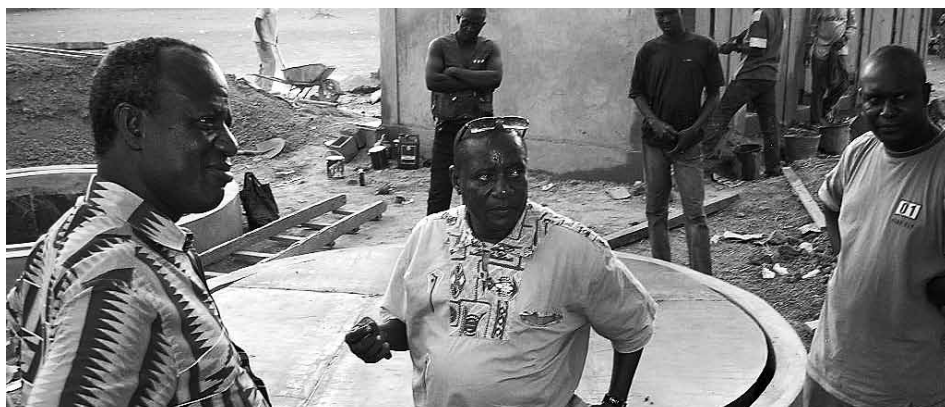
Die Aufsicht der Arbeiten oblag Herrn Oumarou Almoustapha, Experte für Planung und Bau von kleinen Biogasanlagen (Bildmitte)
