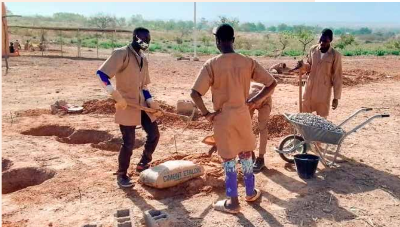
▼ Travaux pratiques : creuser des fosses de fondation
