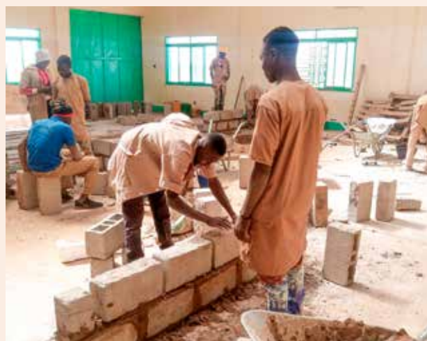
Travaux pratiques : construction d'un mur
