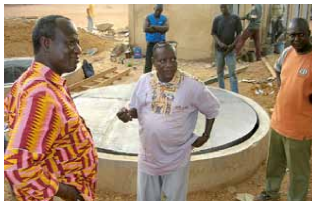
Die Aufsicht der Arbeiten oblag dem Experten für Planung und Bau von kleinen Biogasanlagen, Herr Oumarou Almoustapha (Bildmitte)
