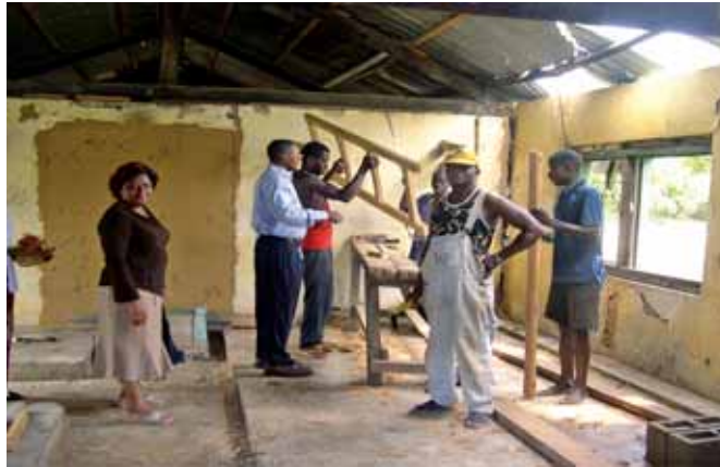
Auch die lokalen Bauschreiner müssen sich den einfachsten Arbeitsbedingungen stellen
